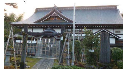
大進坊 伝統の茅葺屋根を千鳥破風先階入母屋造りの銅板屋根に改修(羽黒町手向)
