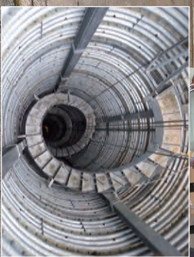
筒状になった掘削箇所にコンクリートを流し込み杭を築造する工事
