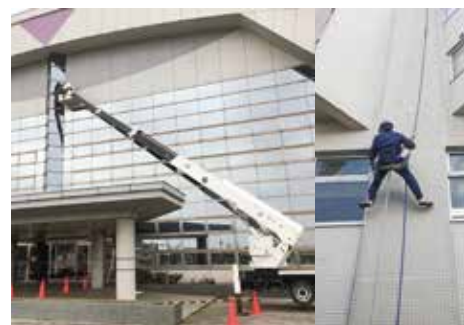
高所作業の様子
