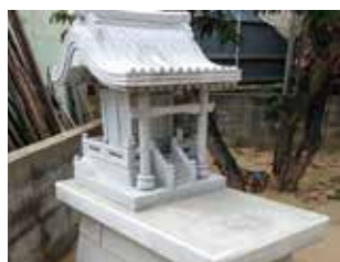
お稲荷様基礎工事
