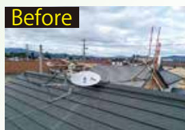
強風で倒れ故障した アンテナの復旧工事
